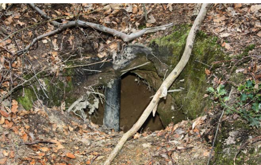
Abb. 36: Ein entgegen der Hangneigung schräg einfallender Tagesbruch gibt den Blick auf einen Stollen frei. Der obere Bereich verdeckt, von oben betrachtet, den Blick auf die Öffnung des Tagesbruchs und den alten Stollen. Im Innern ist ein Holzstempel zu erkennen.
